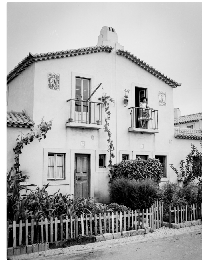
Figura 5 Casa Económica do Bairro da Quinta do Jacinto. Roiz, Lda. Década de 1940. Arquivo Municipal de Lisboa – Fotográfico/PT/AMLSB/CMLSBAH/PCSP/004/ROZ/000026.
