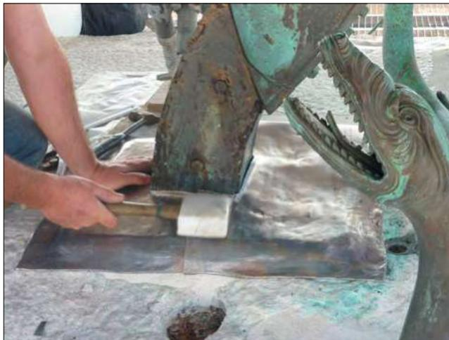
Fig. 43-44 Preenchimento de fissuras e descontinuidades com intuito de minimizar a entrada de águas pluviais. Criação de revestimento adicional nas sapatas de chumbo da estátua, com pendentes, para desvio das águas pluviais.
