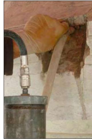
Fig. 26-28 (da esquerda para a direita; de cima para baixo): Remoção de argamassas degradadas das juntas do plinto. Estabilização e colagem de fragmentos de grande porte. Injecção em profundidade em fracturas e juntas de zonas fragilizadas do plinto.
