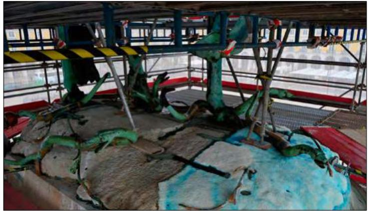
Fig. 25 Limpeza por via química, com compressas, das manchas dos produtos de corrosão da liga metálica que haviam sido absorvidos pelo calcário.
