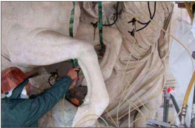
Fig. 24 Limpeza por via húmida, por nebulização de água, com auxílio de escovagem.
