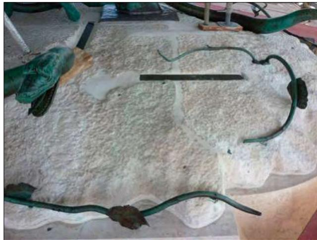
Fig. 30-31 (da esquerda para a direita): Tratamento e selagem de elementos metálicos em ferro no plinto.
