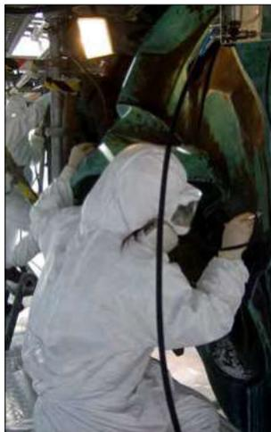
Fig. 35-36 (da esquerda para a direita): Limpeza mecânica de incrustações espessas. Limpeza das pátinas não coesas e não idóneas por microabrasão.
