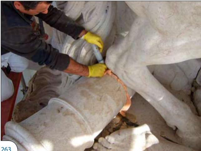
Fig. 29 Injecção em profundidade de junta num dos elementos escultóricos em pedra.
